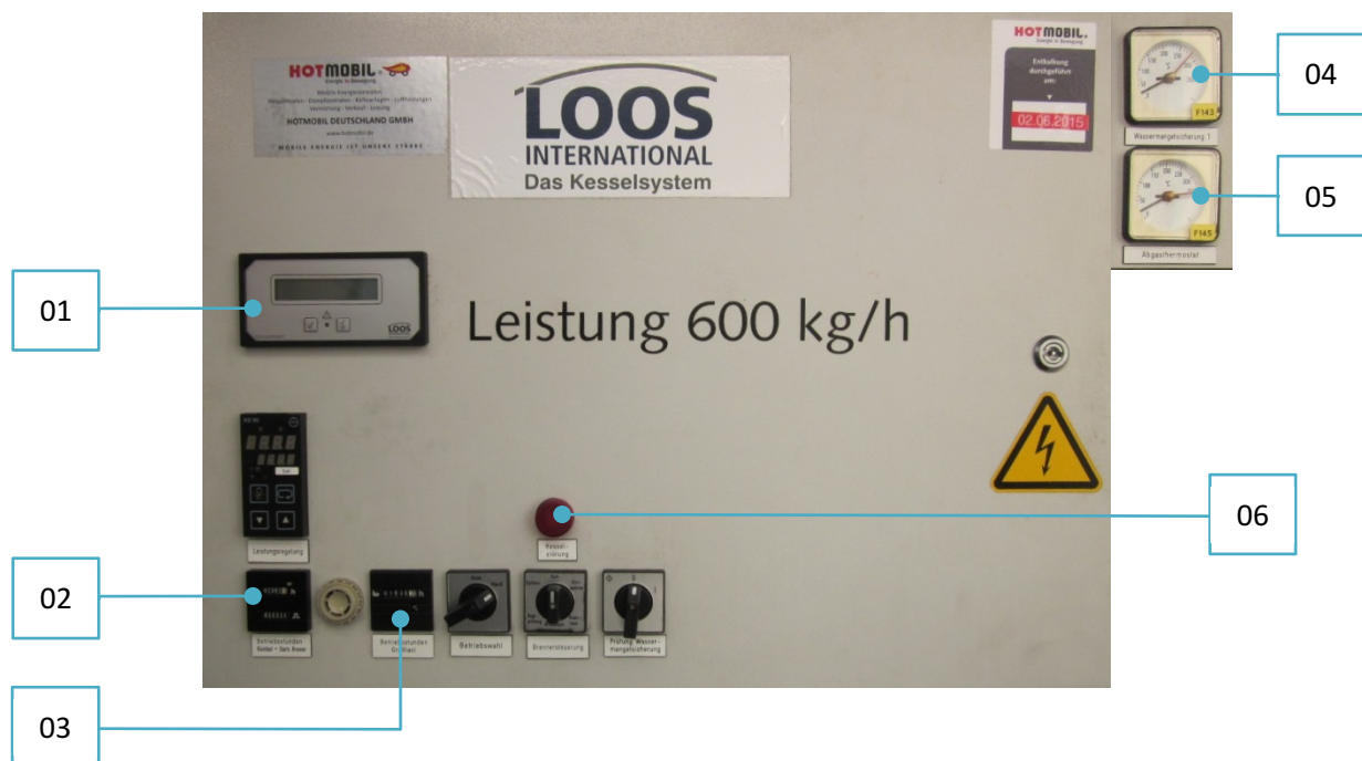
Abbildung 16: Steuerschrank (Anzeige)
