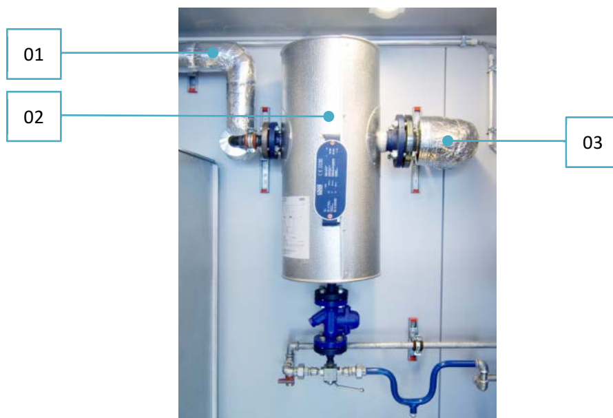
Abbildung 9: Dampftrockner
