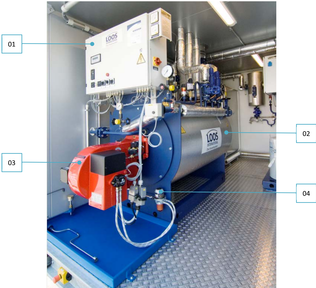
Abbildung 3: Perspektive der Anlage (Dampfkessel)
